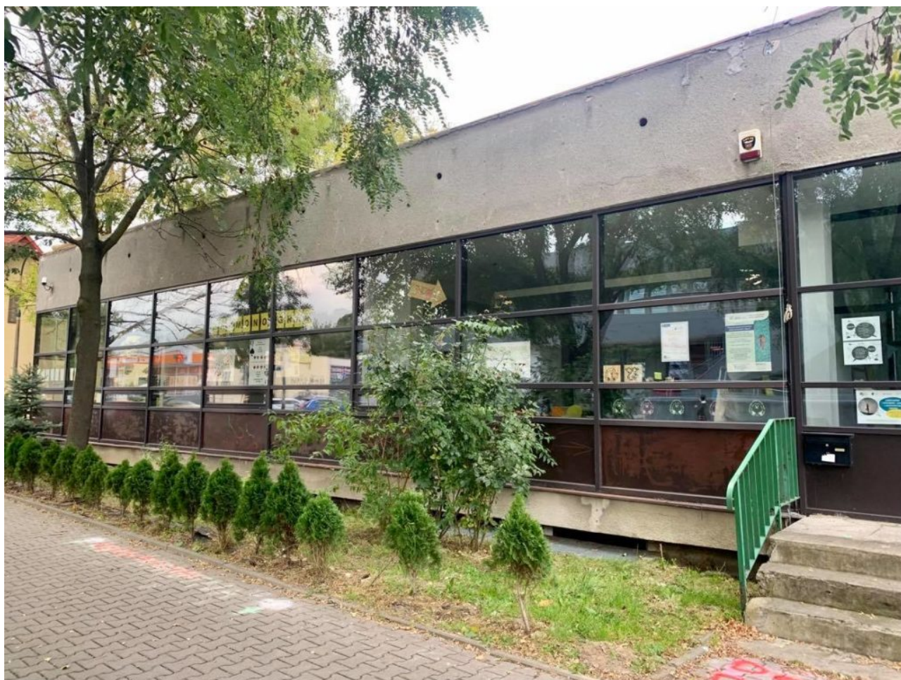
Widok z zewnątrz
